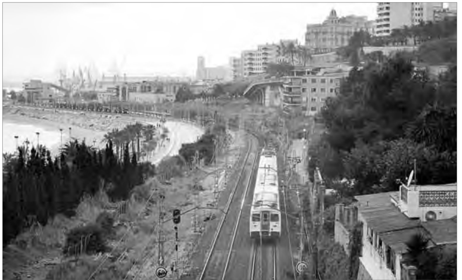
El tercer raíl para adaptar el ancho ibérico al europeo se situaría en la vía más cercana al litoral tarragonense. FOTO: PERE FERRÉ
