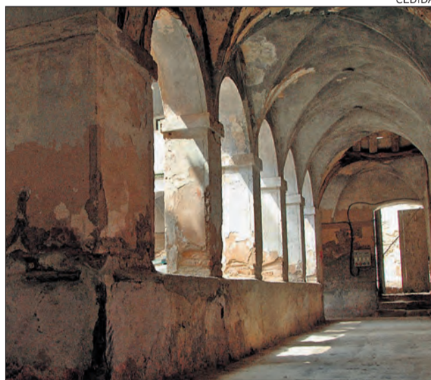
Imatge de la restauració del convent de Santa Anna.
